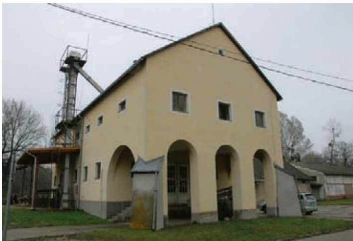
MAGTÁRÉPÜLET A BAROMFI- TELEPEN, ÉPÜLT AZ 1950-ES ÉVEKBEN (FELÚJÍTVÁ 1999-BEN, TAKARMÁNYKEVERŐKÉNT FEL- ÚJÍTVÁ 2011–2013-BAN).
