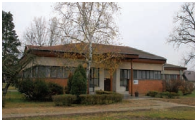
KÁTKI KONFERENCIA KÖZPONT; BÁLDY-TEREM (ÉPÜLT AZ 1970-ES ÉVEK ELEJÉN A KÁTKI ÜZEMI KONY- HÁJAKÉNT, TELJES ÉPÜLETENERGE- TIKAI FELÚJÍTÁSRA ÉS RÉSZLEGES BELSŐ ÁTALAKÍTÁSRA SZORUL).
