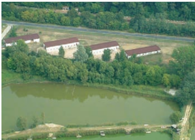
VÍZISZÁRNYAS TELEP (RÉSZLEGESEN FELÚJÍTVA 2011–2013-BAN).
